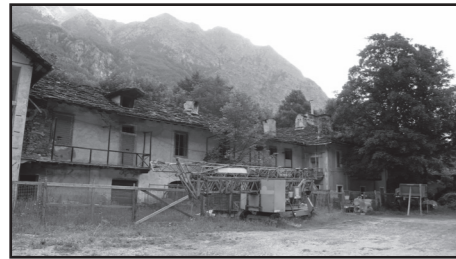
Le bâtiment «C» en 2013. (Photo Ch. Spits)
